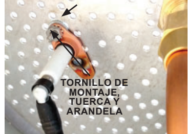
FIGURA 18 LA ANIELA SE DEBE COLOCAR ENTRE EL ENCENDEDOR Y LA PLACA DEL QUEMADOR
